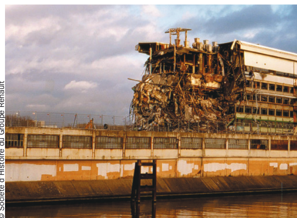
✓ Mars 2004 : début de la démolition de l'usine Renault.
